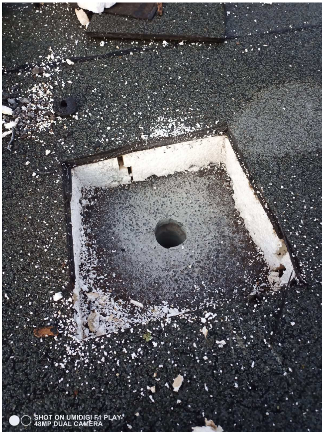
Geöffneter Dachaufbau bis Korklage
