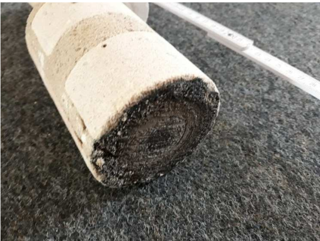
SchwarzAnstrich Wand West zwischen K+S und Klinker
