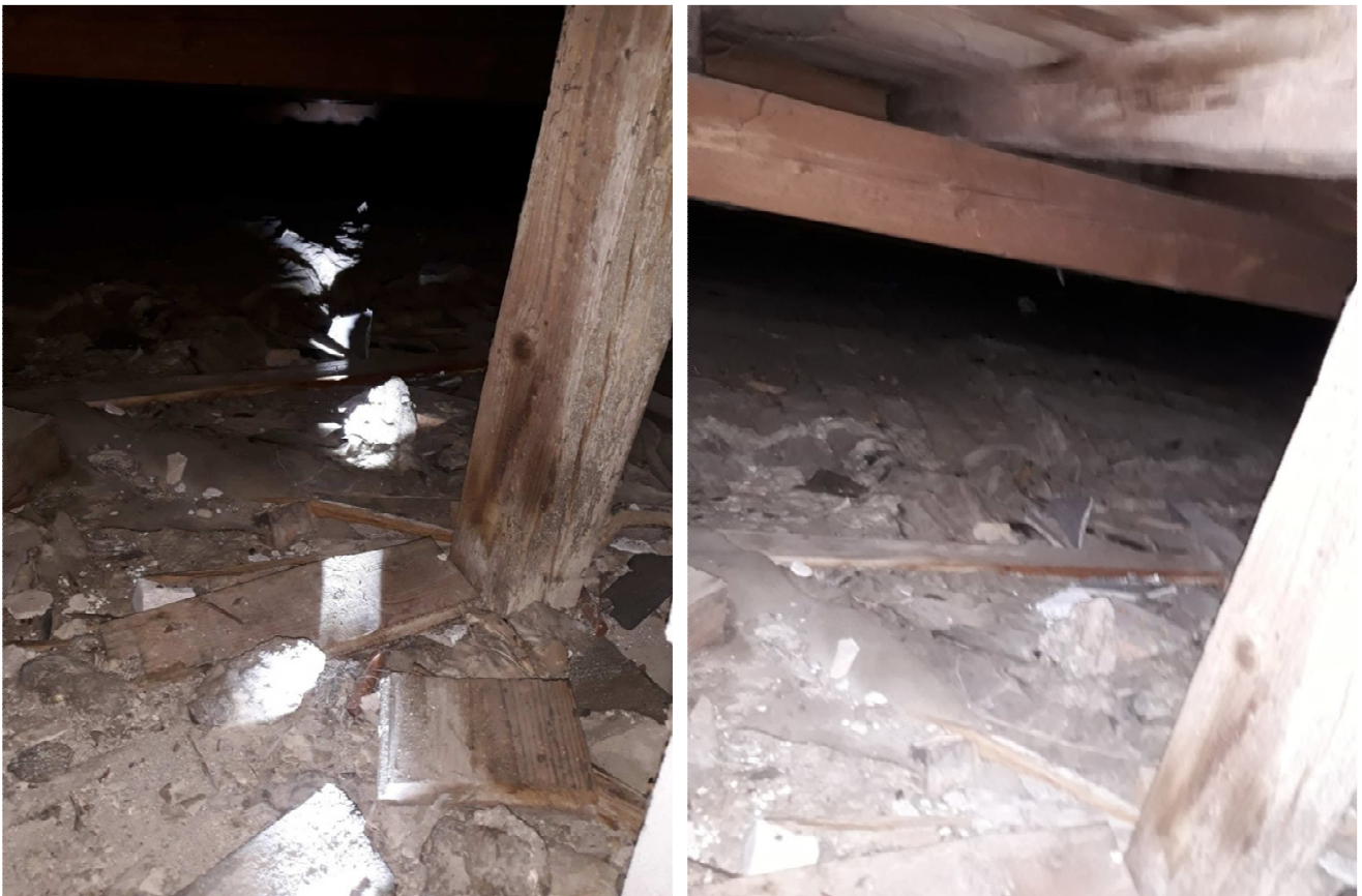
Dämmauflage Geschosdecke Trakt E
